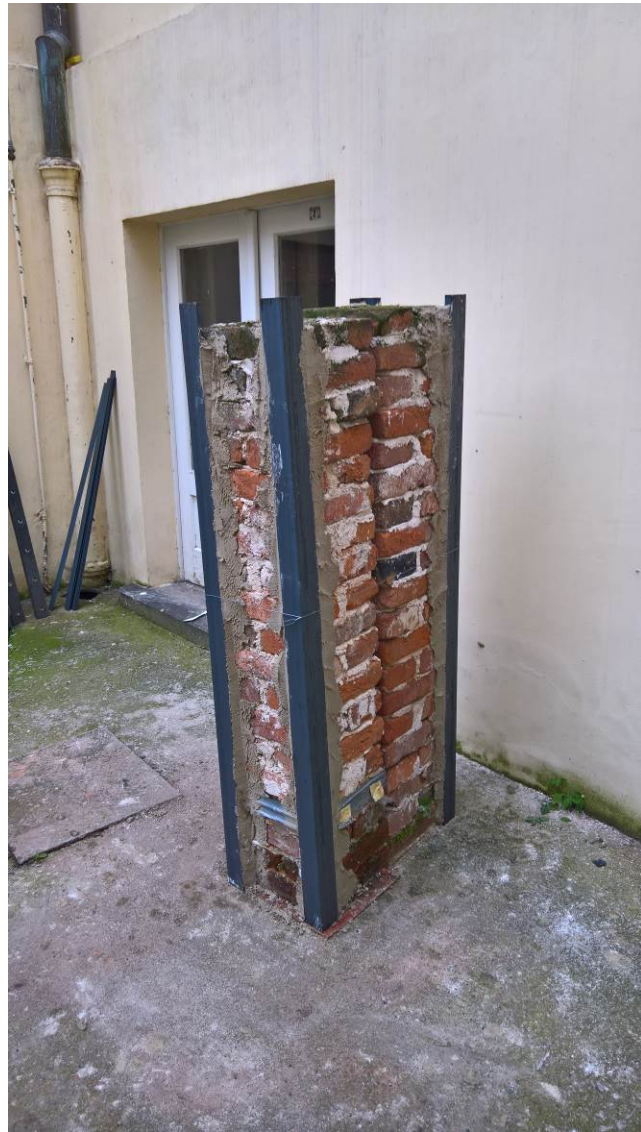
Foto 4., 5.: Pilíř s nárožními úhelníky, osazenými do malty a zajištěnými vazacím drátem
