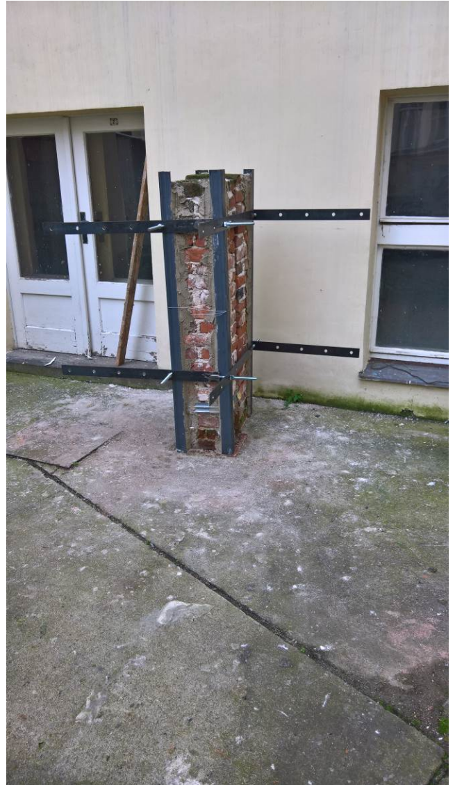
Foto 7.: Pilíř s nárožníky, staženými ve dvou polohách montážními prvky
