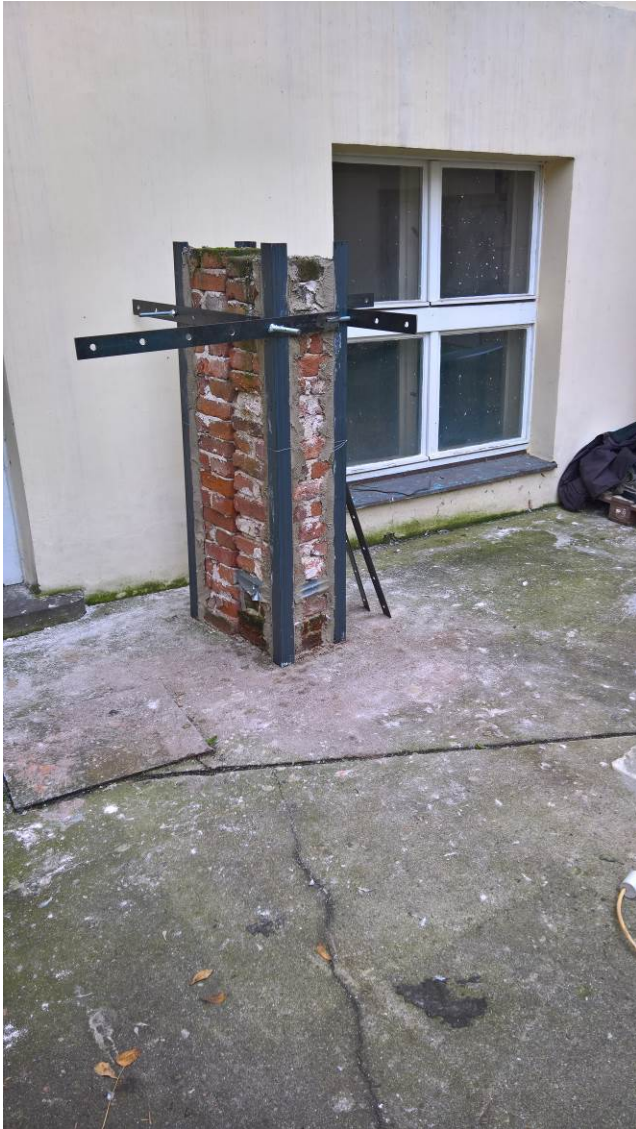
Foto 6.: Čtveřice montážních prvků, osazená v horní poloze
