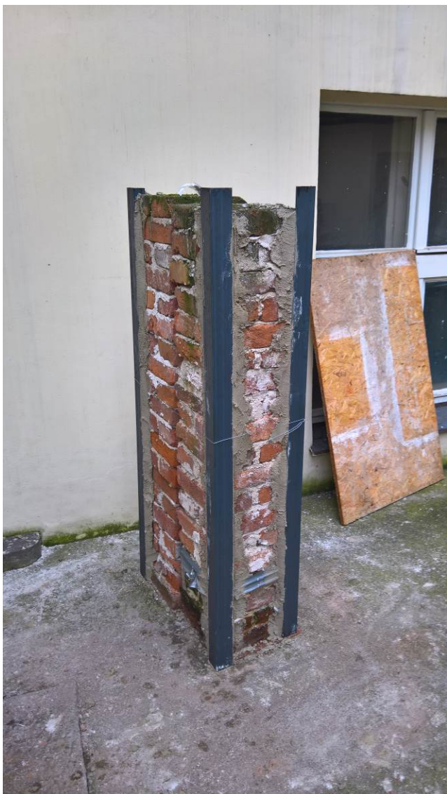
Foto 4., 5.: Pilíř s nárožními úhelníky, osazenými do malty a zajištěnými vazacím drátem
