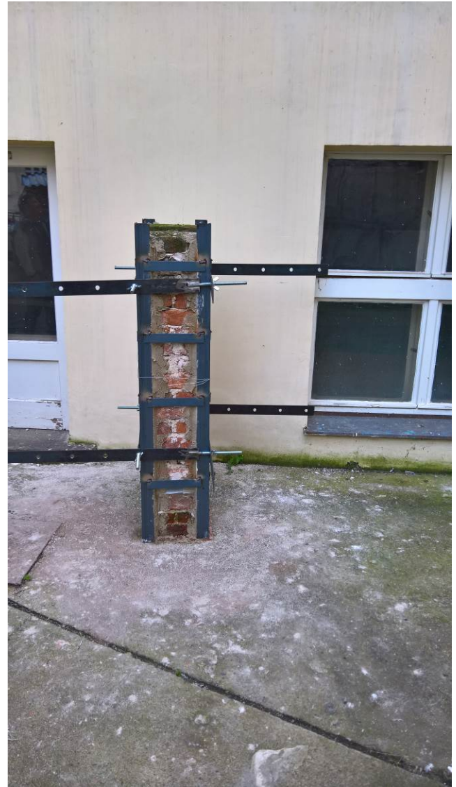
Foto 9.: Pilíř s dokončenou ocelovou objímkou před odstraněním montážní pomůcky
