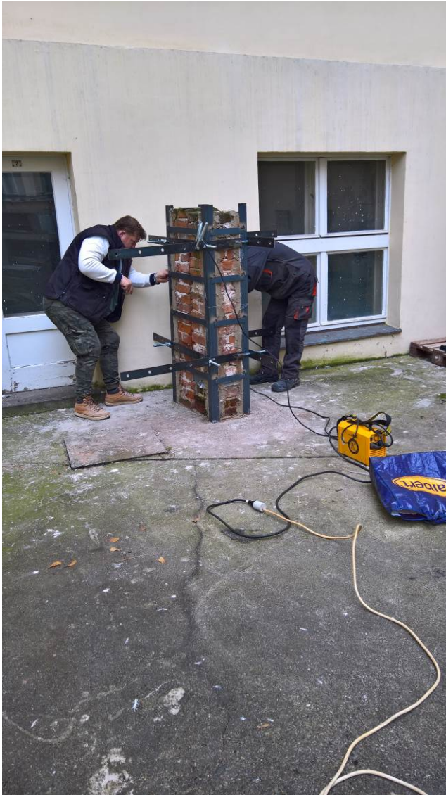
Foto 8.: Navařování spojek z pásového železa mezi nárožníky
