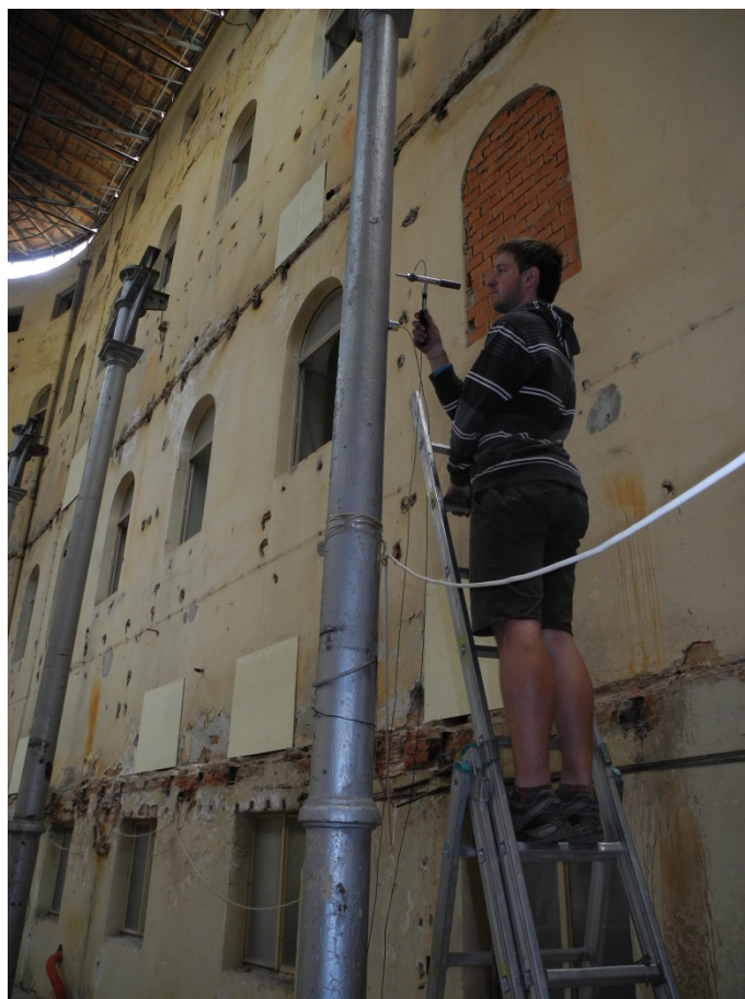
Obr. 9 Zabudovaný sloup dole vetknutý – pracovní označení D
