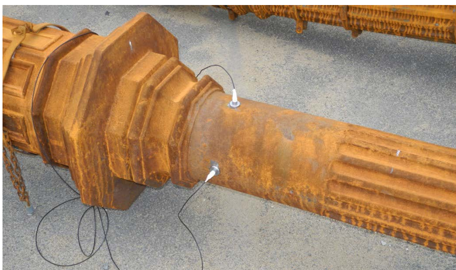
Obr. 16 Umístění snímačů na sloupu
