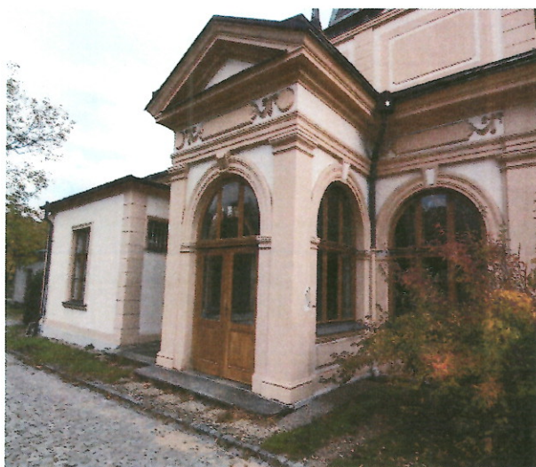
Obr. 6. Pohled na levý výklenek obřadní síně Nového židovského hřbitova na Olšanech
