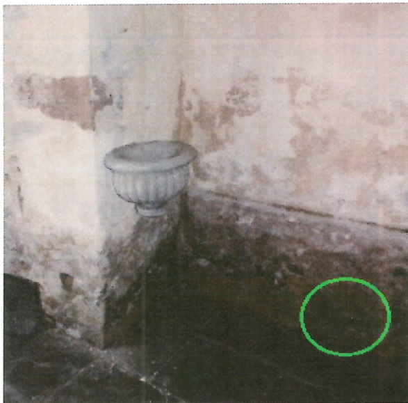
Obr. 12. Vyznačení odběrového místa (S6); v obvodové stěně vstupní předsíně kostela sv. Martina ve Zlaté Olešnici Navarovské s významným zasolením ( \text{NO}_3^- )
