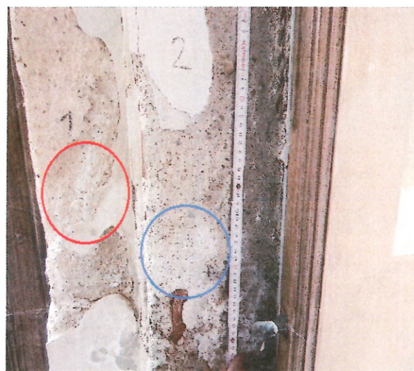
Obr. 7. Vyznačení odběrových míst (1A; 2A) v levém výklenku s významným zasolením ( \text{Cl}^- ; \text{SO}_4^{2-} )
