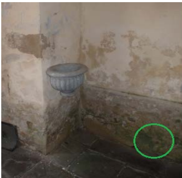
Obr. 15. Vyznačení odběrového místa (S6); v obvodové stěně vstupní předsíně kostela sv. Martina ve Zlaté Olešnici Navarovské s významným zasolením ( \text{NO}_3^- )
