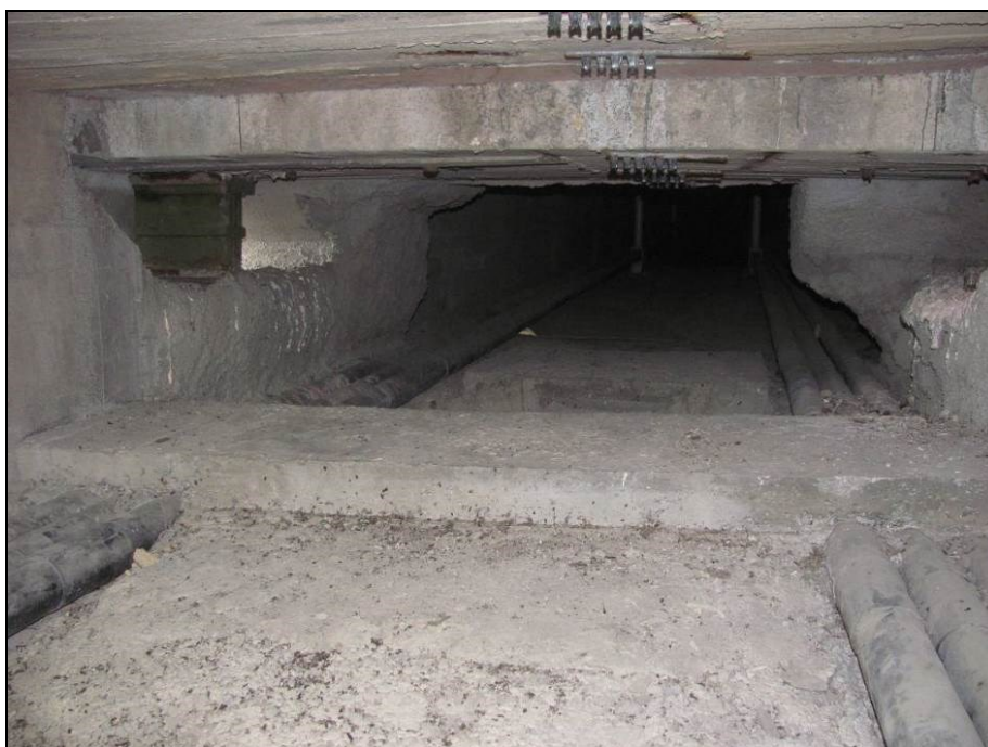
Obr. 5: Detail zmonolitněného kloubu v poli 2 [1]
