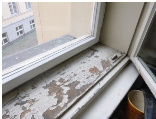
Obr. 2 Detail špalety dvojitě okna
