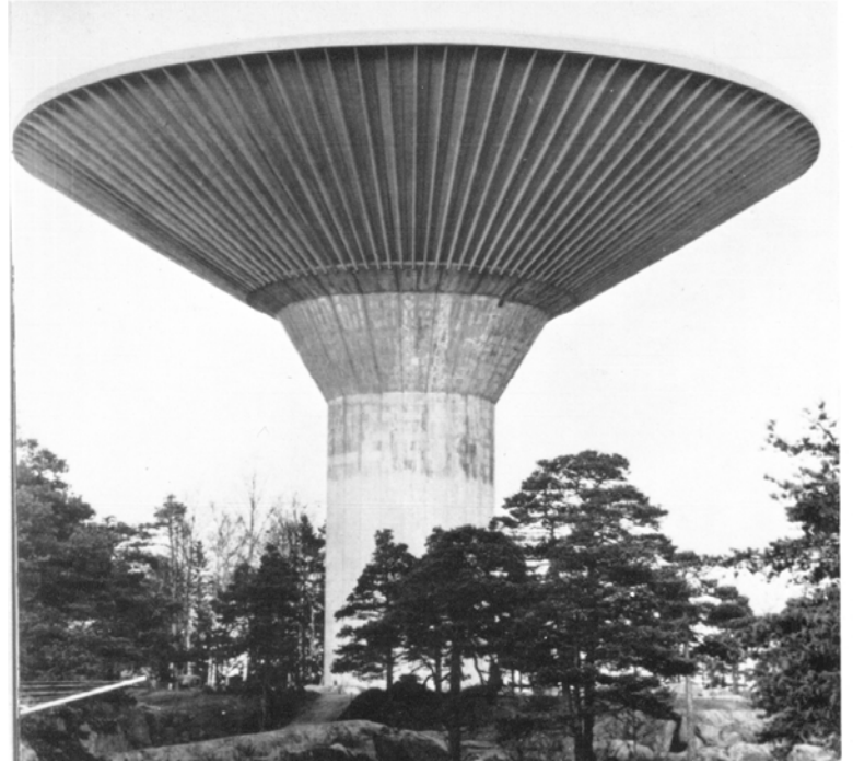
Vodojem ve Finsku
