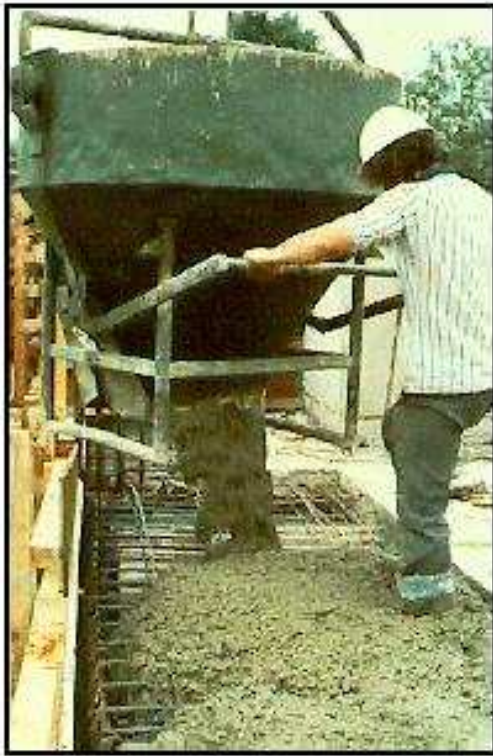
Monolitický beton – betonáž na staveništi
