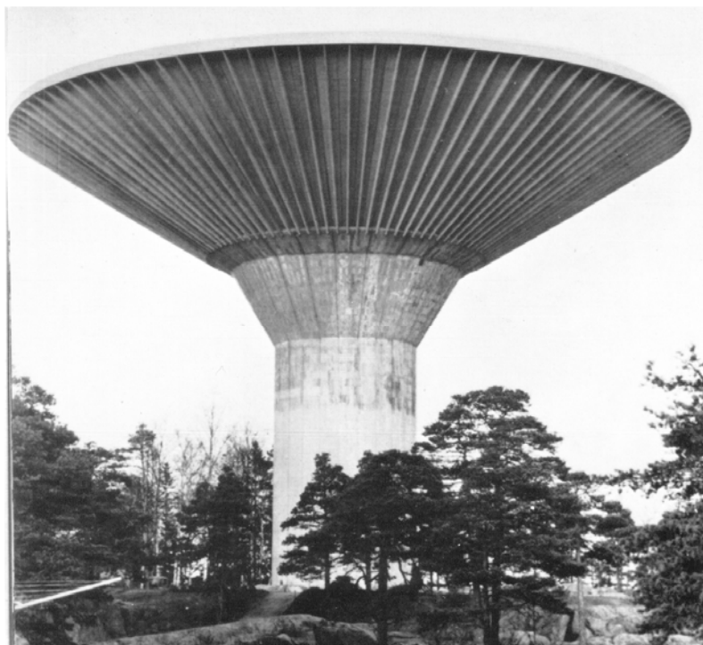
Vodojem ve Finsku
